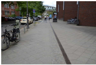
Haupteingang Trebbiner Straße (Altbau)
