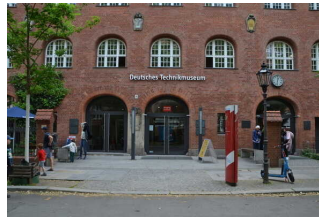
Haupteingang Trebbiner Straße (Altbau)
