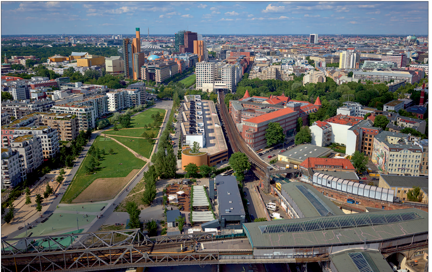
▲ Das Gleisdreieck mit Blick in Richtung Potsdamer Platz. Die neue „City S-Bahn“ verläuft von dort unterirdisch bis zu den weißen Hochhäusern in Bildmitte und von dort aufgeständert über das Parkhaus und den heutigen Biergarten bis zur U-Station. Foto: DB Netz AG
