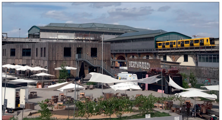
▲ Der Kreuzungsbahnhof Gleisdreieck heute, oben verläuft die Linie U1, unten fährt gerade ein Zug der U2 in Richtung Zoo/Ruhleben aus. Parallel zur Bahnsteighalle der U2 soll sich ab 2030 die neue S-Bahn-Station befinden – genau dort, wo heute das holzverkleidete Gebäude steht. SDTB / Foto: Lars Quadejacob
