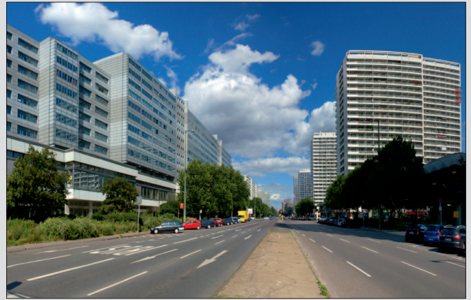
▲ Straßenprofil neu: Die Leipziger Strasse Höhe Markgrafenstrasse, Blick Richtung Spittelmarkt.
