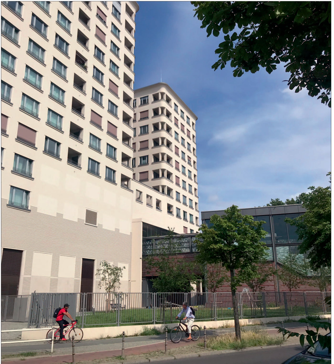
▲ Im Hochhauskomplex neben und über der U-Bahn-Station Mendelssohn-Bartholdy-Park wurde eine Aussparung für die künftige S-Bahn-Linie belassen. Dieses ist seit einigen Jahren durch eine Scheinmauer kaschiert, deren Lage sich gut durch die im Putz angedeuteten Fensteröffnungen erkennen lässt. SDTB / Foto: Lars Quadejacob
