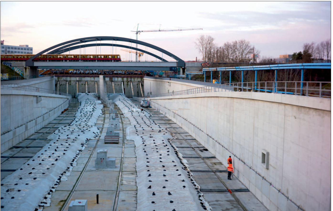
▲ Baustelle des Bauabschnitts 16 in Treptow, 2020. Der geplante 17. Bauabschnitt soll die A 100 bis zur Storkower Straße in Lichtenberg führen. Foto: mompl, flickr.com
